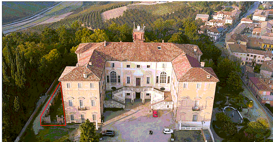
Il castello reale di Govone è un'ex-residenza sabauda che domina il paese: a sinistra, nell'area evidenziata di rosso, il muro oggetto del contendere
